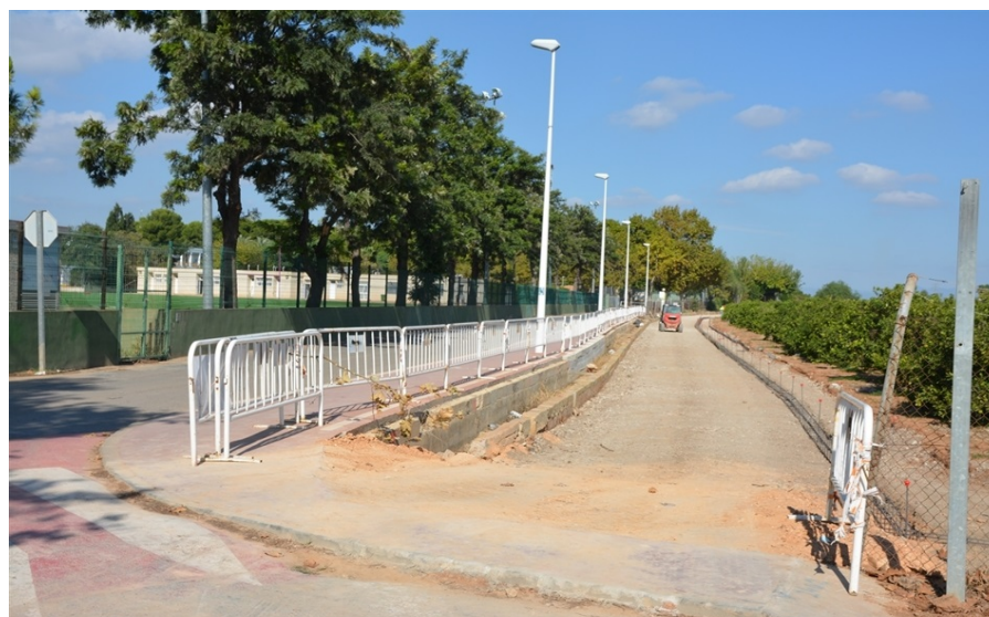
Fig. 7 Ampliación del camino de acceso al Polideportiv.
